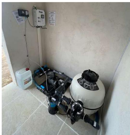
Le filtre à sable est l'un des filtres les plus répandus dans les piscines privées. Il s'agit d'une cuve dans laquelle on dispose du sable qui retient les impuretés passant dans l'eau de la piscine. Le filtre à sable est assez encombrant et il n'est pas le plus efficace puisque sa finesse de filtration est de 20 à 40 microns, à moins que vous n'ajoutiez un flocculant, ce qui améliore sa finesse de filtration. Le sable doit être changé tous les 5 ans en moyenne.
