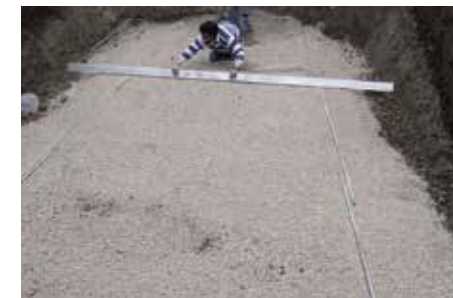
4/ Préparation du sol / Radier
