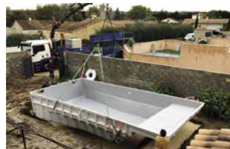
6/ Grutage - mise en place et calage
